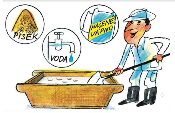
Je to bílá, ve vodě málo rozpustná látka. Vyrábí se reakcí oxidu vápenátého (páleného vápna) s vodou (hašení vápna):
